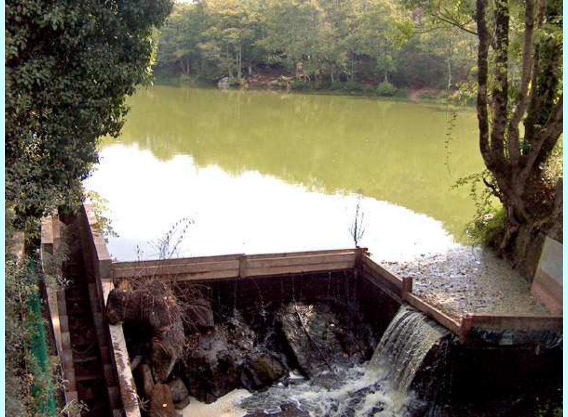
Déversoir de retenue lors d'un étiage très sévère
